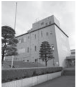
本庄市水道庁舎
