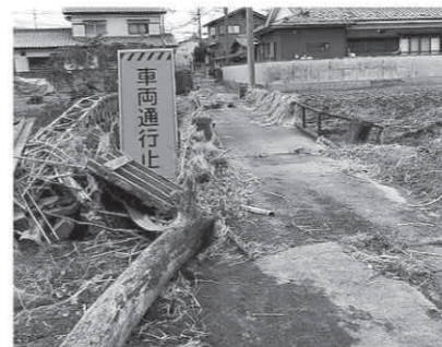
台風19号後の蛭川地区の様子
