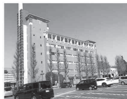
本庄市役所(本庁舎)
