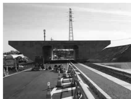
市道第1305号線箱型函渠 (沼和田地内)
