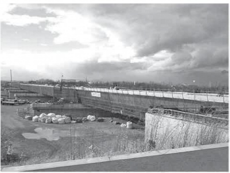
神流川橋の架け替え (埼玉県側から高崎方面を撮影)
