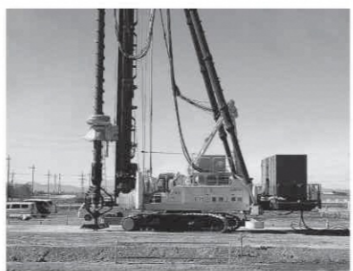
国道17号本庄道路の工事 (沼和田地内)
