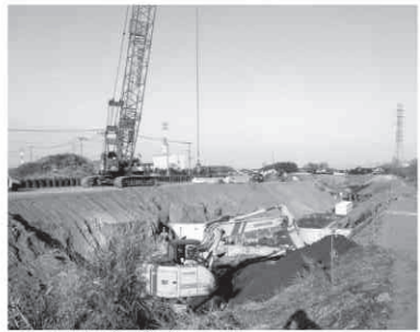
先蔵木堰の撤去の様子
