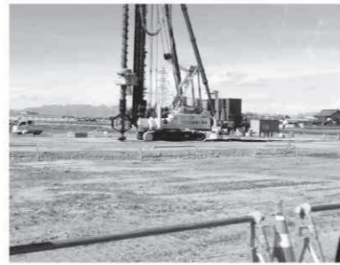
工事中の17号バイパス(沼和田地区)
