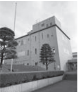
本庄市水道庁舎
