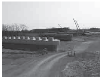
神流川橋架替工事現場 (群馬県側から見た橋脚)
