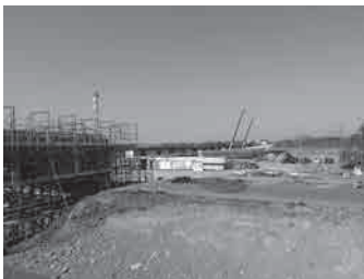
神流川橋架替工事現場 (埼玉県側から見た橋脚)
