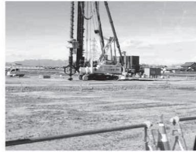
工事中の17号バイパス(沼和田地区)
