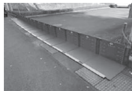
止水板の設置例
