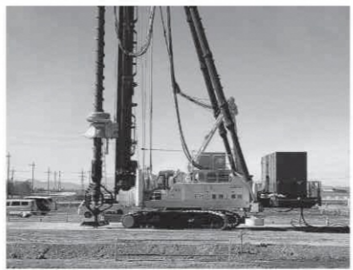
国道17号本庄道路の工事 (沼和田地内)
