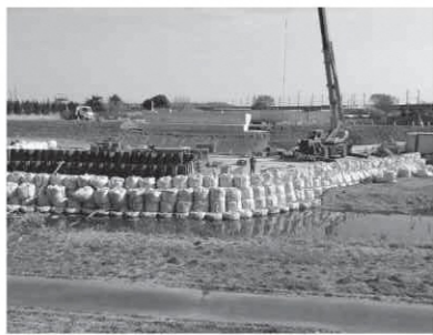
小山川橋梁工事 (シルクドーム付近から深谷方面を撮影)
