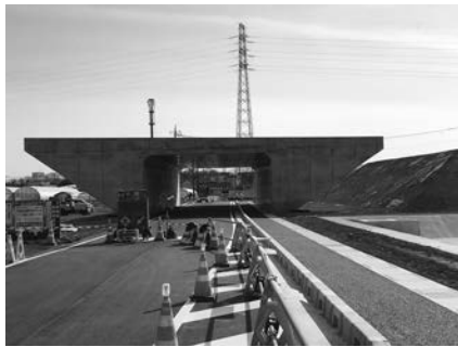
市道第1305号線箱型函渠 (沼和田地内)
