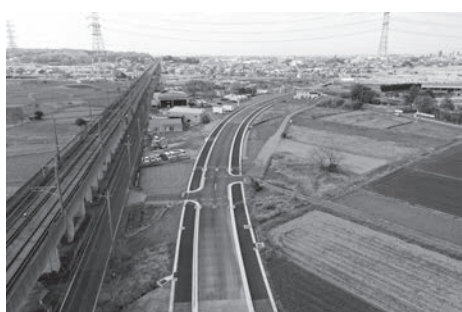
県道花園本庄線の道路建設状況
