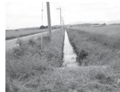
用排水路と市道(旧農道)
