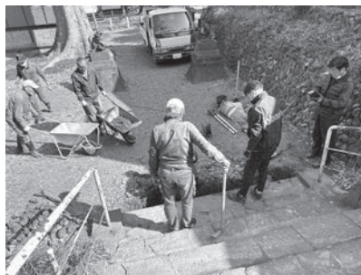
有志における参道整備の様子
