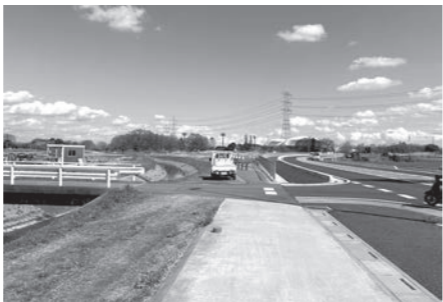
県道花園本庄線バイパスの接続道路
