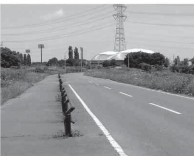
県道花園本庄線のバイパス予定地
