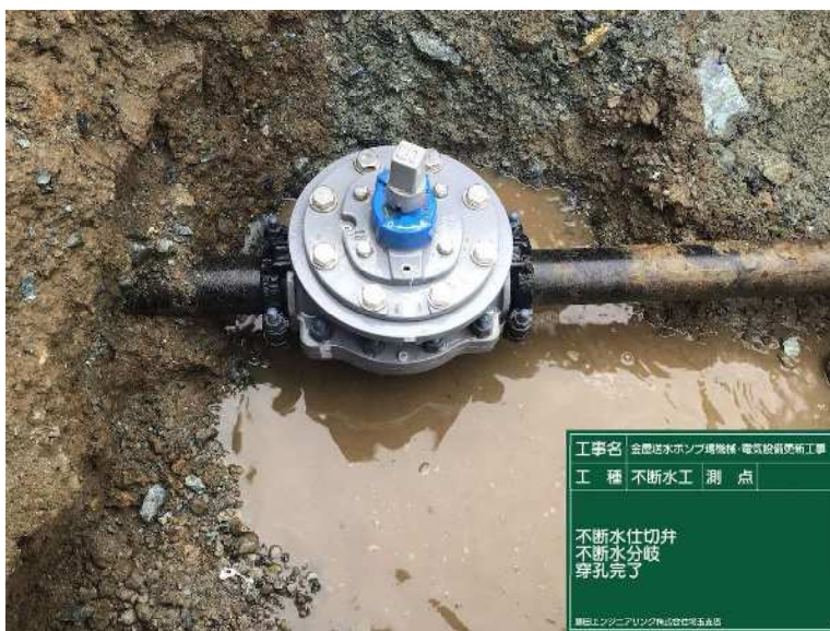
工事名 金網送水ポンプ増設機・電気設備更新工事 工種 不断水工 測点 不断水仕切弁 不断水分岐 穿孔状況 株式会社エンジニアリング検査技術センター
