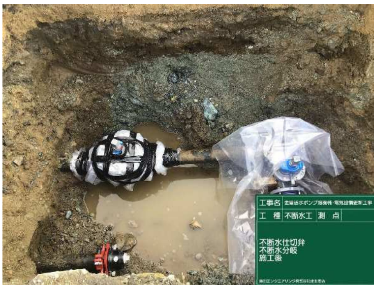
工事名 金網送水ポンプ増設機・電気設備更新工事 工種 不断水工 測点 不断水仕切弁 不断水分岐 穿孔完了 株式会社エンジニアリング検査技術センター
