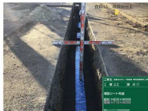
資料15. 埋設シート付設
