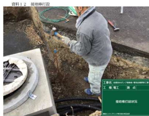
資料12. 接地棒打設
