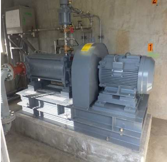
ア No 1 送水ポンプ設置
