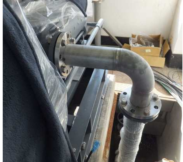
イ No2 送水ポンプ設置工事
