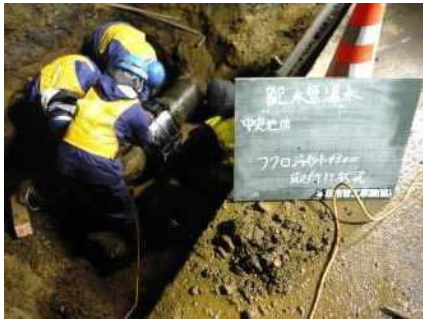
漏水箇所の修繕
