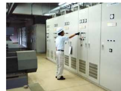
電気設備の点検
