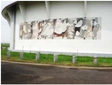
第二浄水場 応急給水栓
