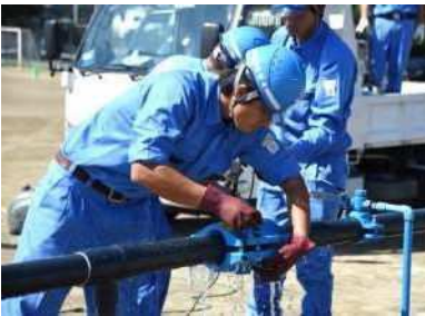
水道復旧訓練
