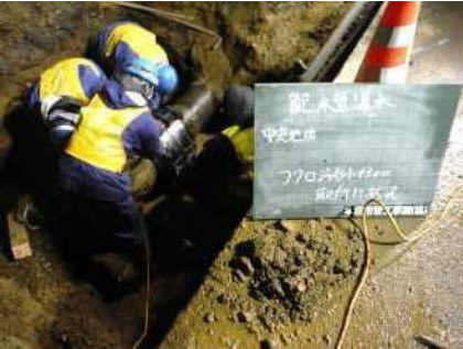
漏水箇所の修繕
