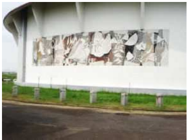
第二浄水場 応急給水栓
