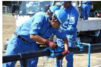
水道復旧訓練
