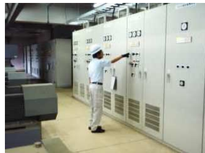
電気設備の点検
