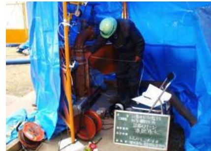
揚水試験による井戸能力の確認
