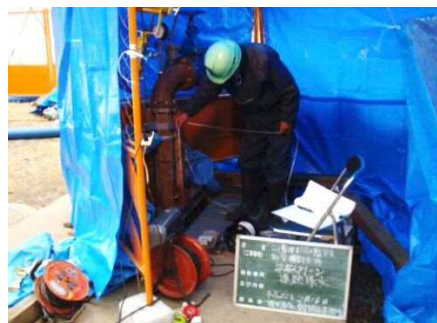
揚水試験による井戸能力の確認
