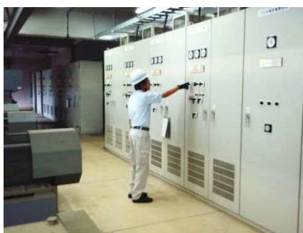
電気設備の点検
