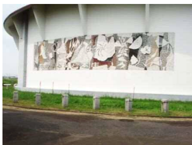
第二浄水場 応急給水栓
