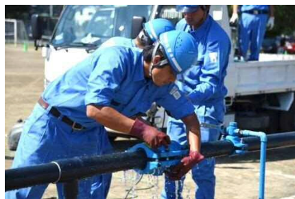
水道復旧訓練
