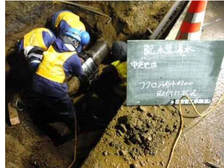
漏水箇所の修繕
