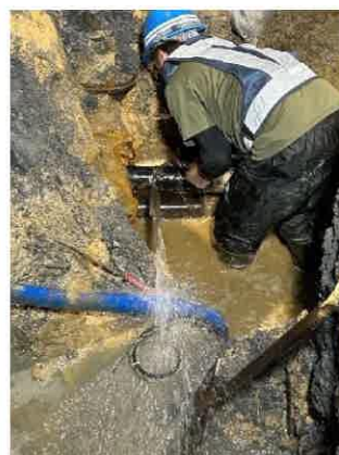
漏水箇所の修繕
