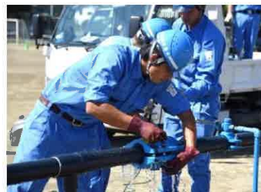
水道復旧訓練
