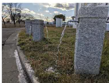
第二浄水場 応急給水柱
