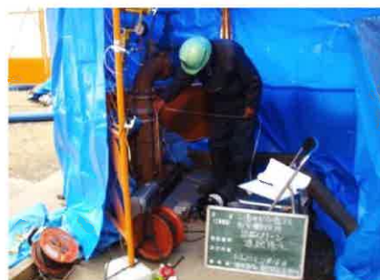
揚水試験による井戸能力の確認
