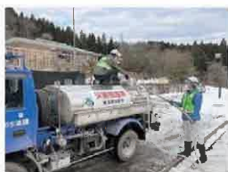
・給水車へ補水の状況 (輪島市地原浄水場)
