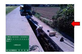
※児玉地域における老朽 管更新工事です。老朽化 した塩化ビニル管を耐震 能力を有するダクタイル 鋳鉄管に更新していま
