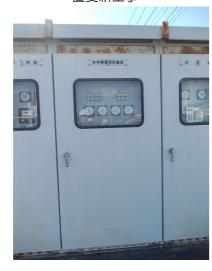
※災害等における停電に備えるた めの設備で、老朽化により更新を 行うものです。 1998年製
