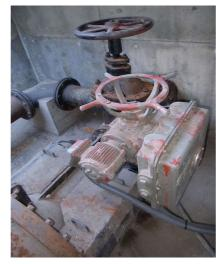
※本庄地域より送水される浄水を受水する ために制御する機械設備で、老朽化により 更新するものです。 1993年製
