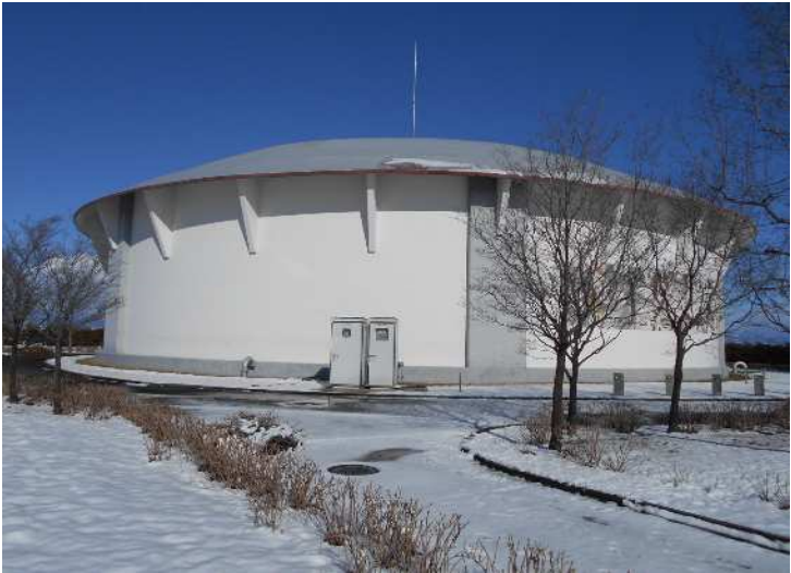
【耐震化工事を必要とする第二浄水場第3配水池】
