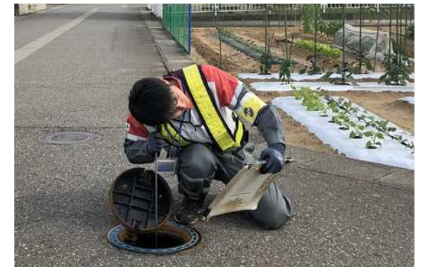
給配水管漏水調査業務の状況
