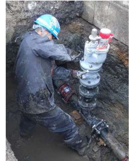
消火栓の漏水修繕の状況
