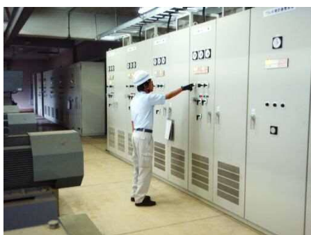
電気設備の点検
