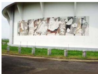
第二浄水場 応急給水栓
