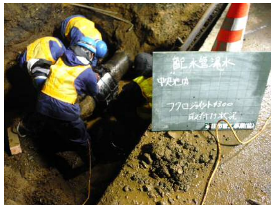
漏水箇所の修繕
