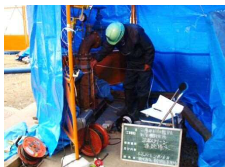
揚水試験による井戸能力の確認
