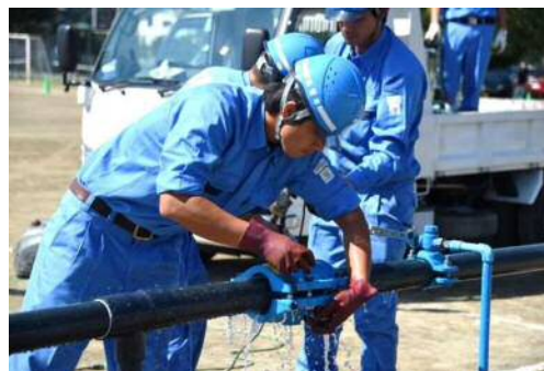
水道復旧訓練
