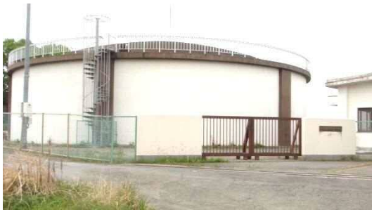
太駄上配水場・平沢送水ポンプ場
