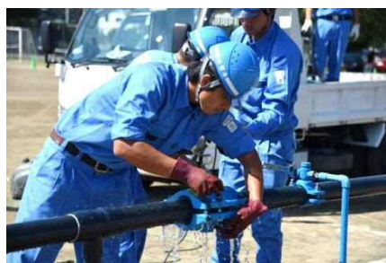
水道復旧訓練
