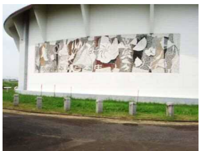
第二浄水場 応急給水柱
