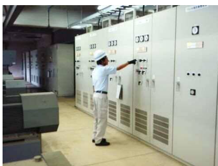
電気設備の点検
