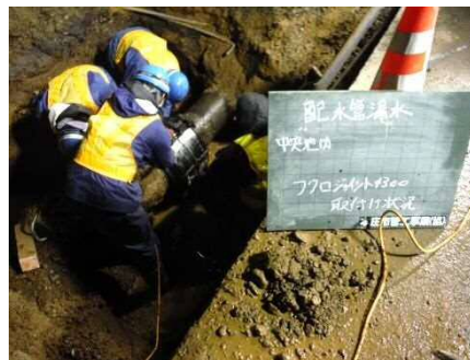
漏水箇所の修繕
