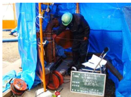
揚水試験による井戸能力の確認
