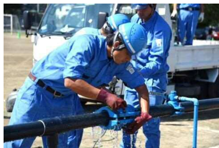
水道復旧訓練
