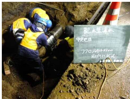
漏水箇所の修繕
