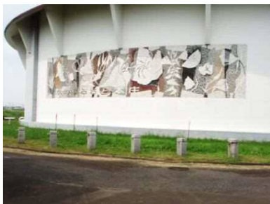
第二浄水場 応急給水栓
