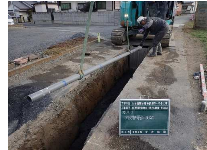
【上水道配水管布設替工事】
