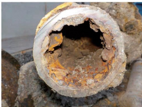
古い管の内部
