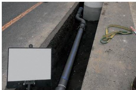
耐震性能を有した管路の工事の施行状況
