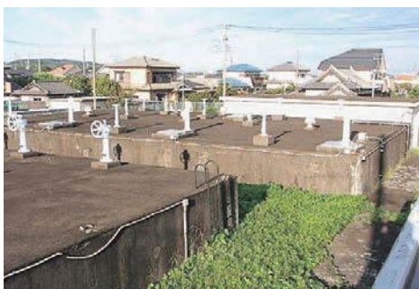
耐震化を必要とする施設(児玉浄水場)
