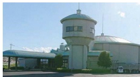
耐震化や浸水対策を必要とする施設(都島浄水場)
