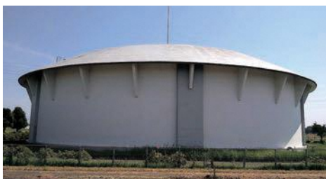
耐震化や浸水対策を必要とする施設(第二浄水場)
