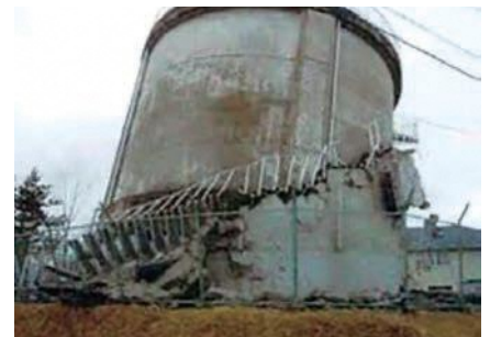
地震災害により倒壊した配水池 (厚生労働省健康局水道課資料より抜粋)
