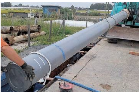
耐震性能を有した管路の工事の施行状況
