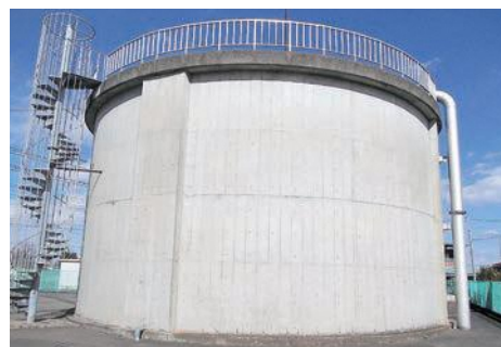
耐震化を必要とする施設(下真下受水場)
