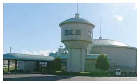
●耐震化や浸水対策を必要とする施設（都島浄水場）
