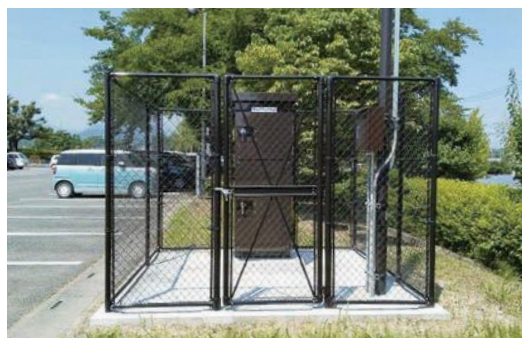
・新設した配水モニター（水質監視装置）
