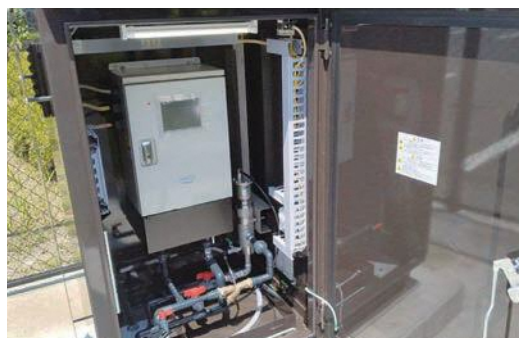
・新設した配水モニター（水質監視装置）
