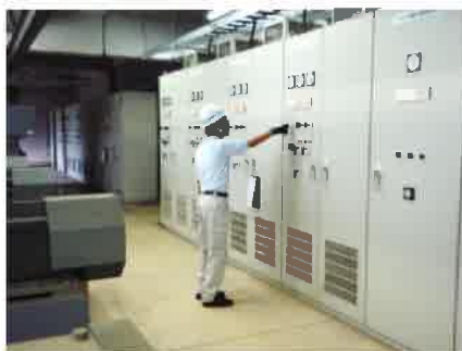
電気設備の点検
