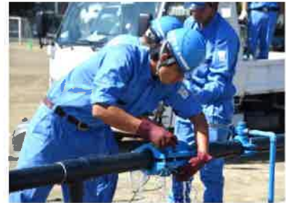
水道復旧訓練
