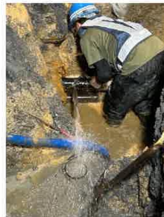
漏水箇所の修繕
