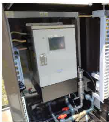
既設水質自動計測装置
