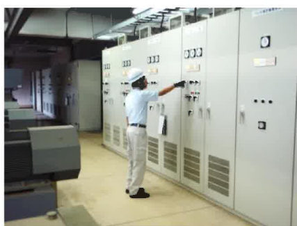
電気設備の点検
