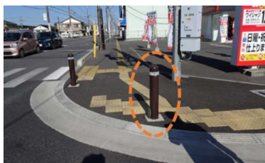
▲ 視覚障害者誘導用ブロック上の車止め(29)
