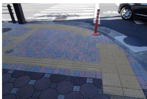
▲ 交差点部の歩道での傾斜(28)
