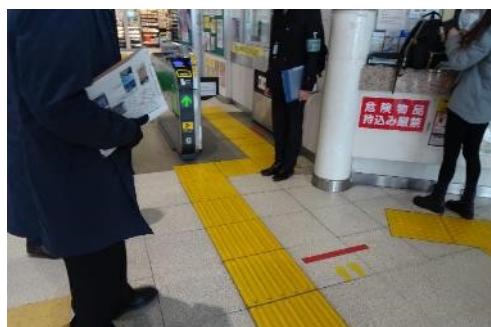
▲ 改札前の視覚障害者誘導用ブロック(40)
