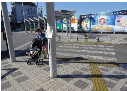
▲南口広場の横断歩道付近の車止め(54)
