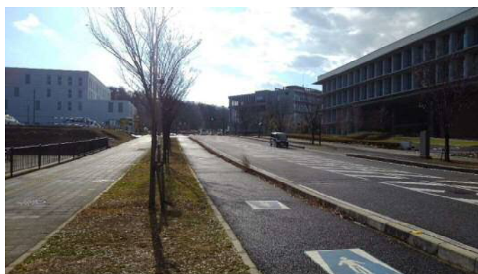
図 2-8 無電柱化整備済み路線（本庄市道第 8601 号線（新駅北口駅前線））
