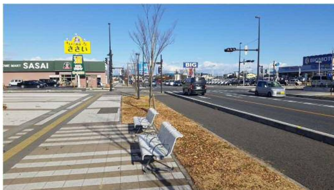
図 2-7 無電柱化整備済み路線（本庄市道第 130 号線（中央通り線））
