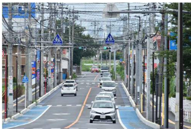
図 2-12 バリアフリー整備済み路線（市役所通り）
