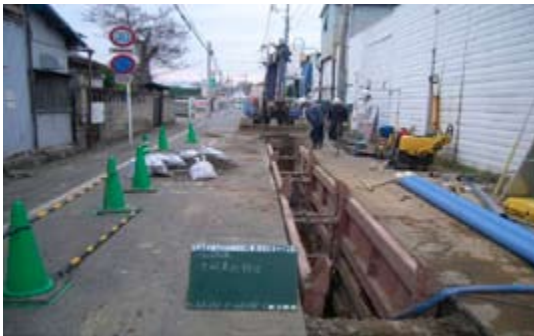
▲公共下水道工事
