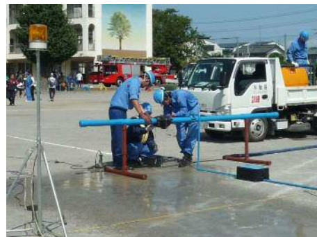
水道管復旧訓練
