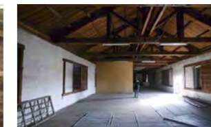
▲2階の無柱空間
