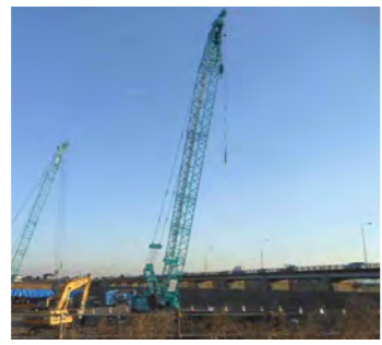
▲建設中の国道17号本庄道路の様子
