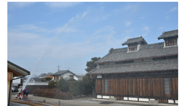
文化財防火デーは世界最古の木造建造物である法隆寺金堂が炎上し、壁画が焼損した日であることから定められた
