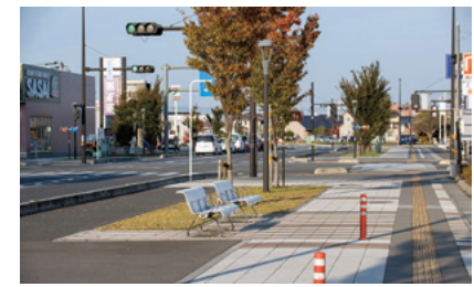
道路整備 緑豊かな並木が連続し、ゆとりある歩行空間、自転車空間が設けられています。
