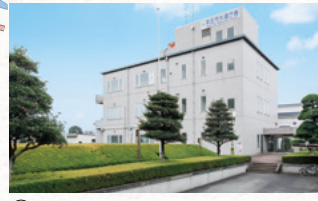
㉓ 水道庁舎
