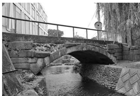
石造アーチ橋として県内最古の寺坂橋
