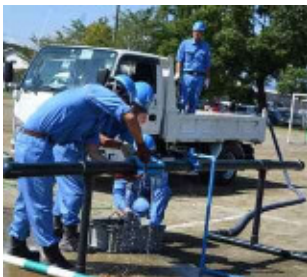
水道管復旧訓練
