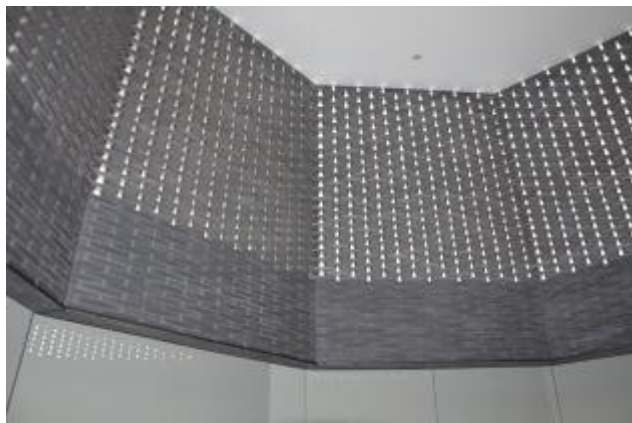
←展示室壁面 （展示ケースの上部）の透かし煉瓦
