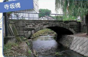
明治22年(1889)に旧伊勢崎道の元小山川に架けられた石造アーチ橋です。近代的な切石を用いたアーチ橋で現在現役の石造アーチ橋としては埼玉県最古の橋です。
