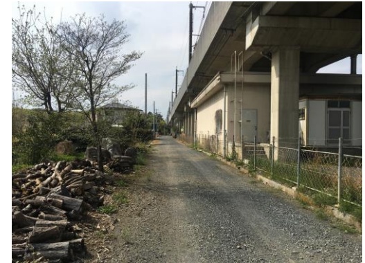
舗装されていない道路
