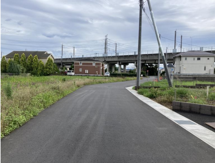
未整備の都市計画道路（新都心環状線）
