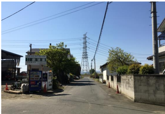
側溝が未整備の道路
