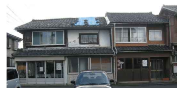
改築前（空き家3軒）
