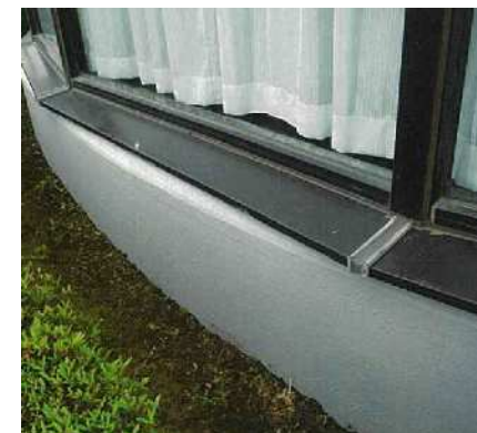
図書室東側サッシ下防水修繕
