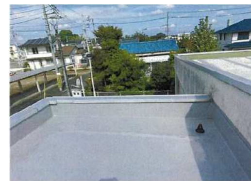
本庄南公民館風除室雨漏り修繕
