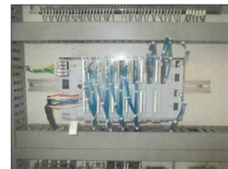
CP-2盤 リモートユニット修繕
