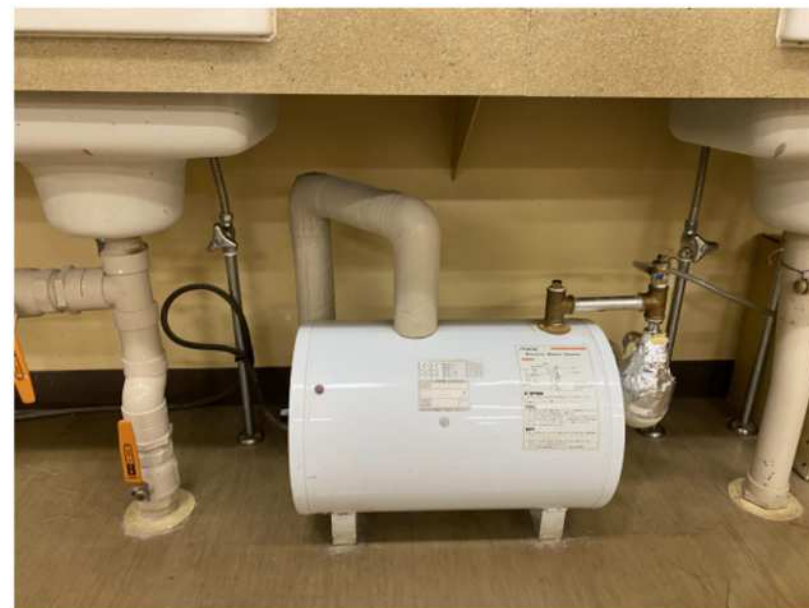
児玉中央公民館美術工芸室電気温水器 交換修繕
