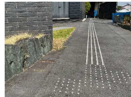
アスファルト舗装施工
