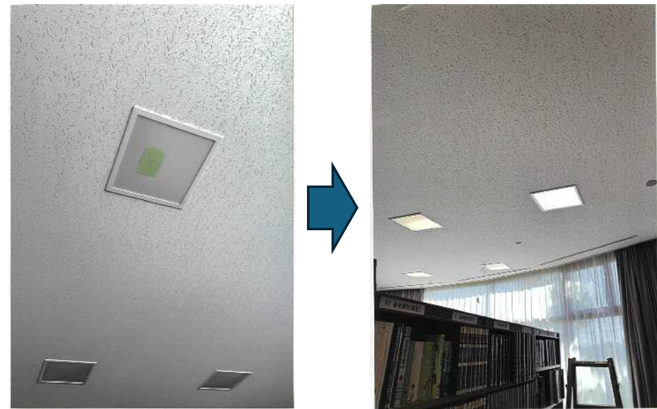
図書館照明器具交換修繕
